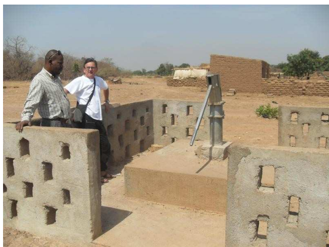
Puits équiper d'une pompe manuelle à surcreuser
