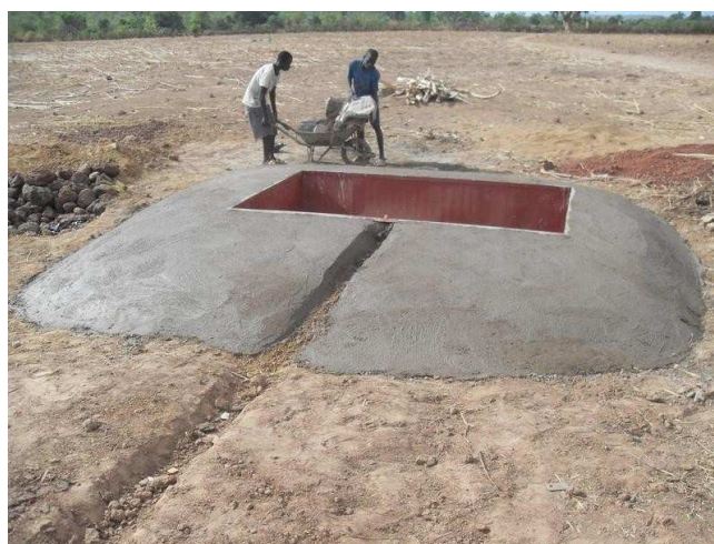
Mise en place de l'abreuvoir en cours
