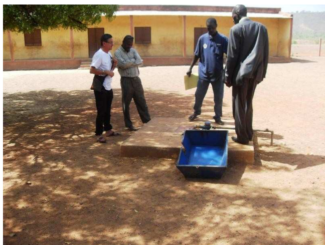
Le puits de l'école qu'il faut démonter, re-creuser et remonter
