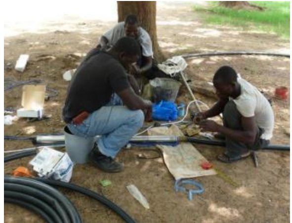
Mise en place du mini réseau
