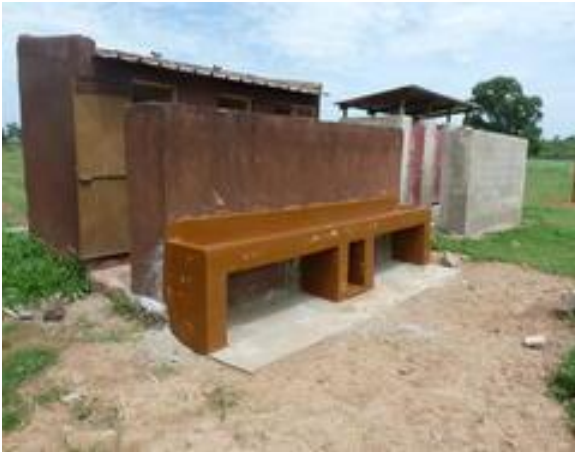
Nouvelles latrines et point d'eau
